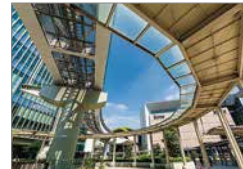
JR 立川駅北口デッキ周辺
